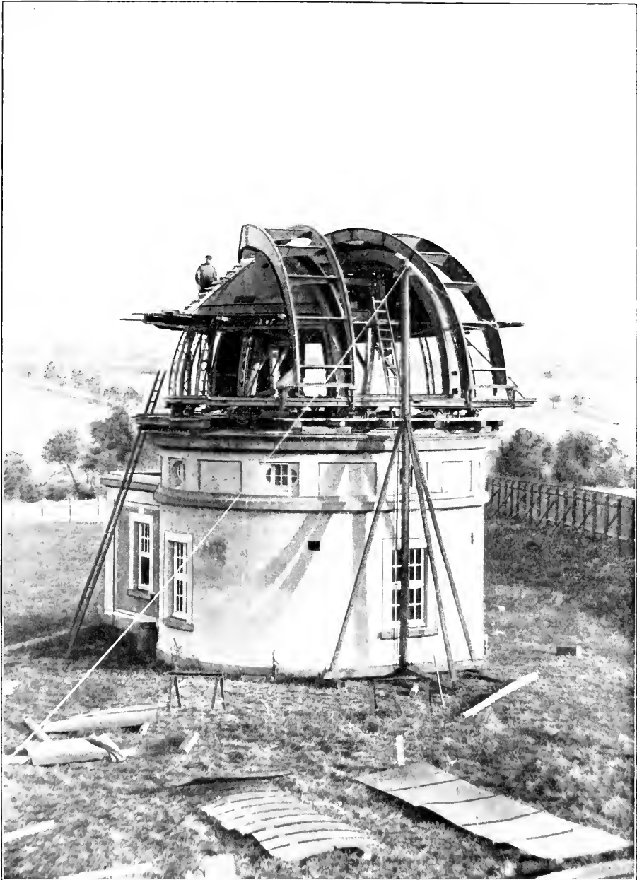
Kuppel für den Lippert-Astrographen im Bau
